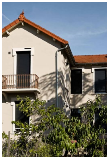
BASA architectes - Réhabilitation et extension d'un pavillon
